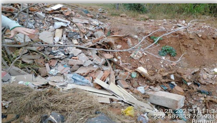
Imagem 76 - Entulho em saída de dispositivo de drenagem
