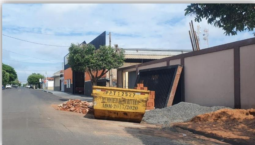
Imagem 97 - Acondicionamento dos resíduos da construção civil
