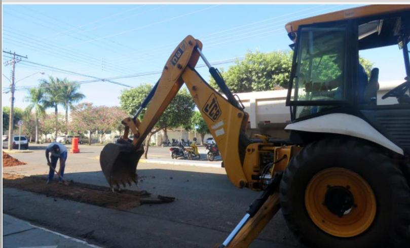
O Serviço Autônomo de Água, Esgoto e Meio Ambiente (SAAEMB) começou hoje (20) a colocar em operação a substituição de canos de amianto por PVC em trechos da avenida Frei Marcelo Manília. Com a medida, a autarquia reduz o risco de vazamento de água, já que os tubos antigos serão substituídos, além de retirar o amianto da rede de abastecimento.
